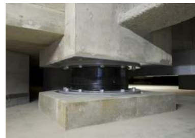
Figura 22. Aislador sísmico implementado en un edificio. Sacada de IngeCivil (2018) ( https://www.ingecivil.net/2018/08/13/funcionan-los-aisladores-sismicos/ )
